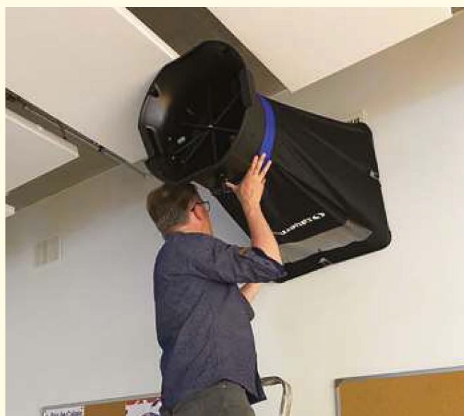
Mesure de débit avec un balomètre.
